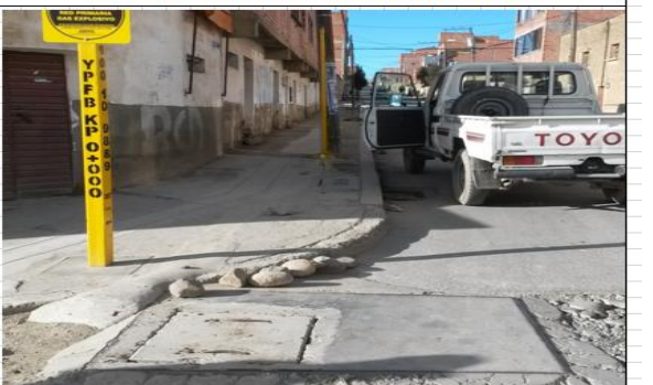
CÁMARA EXTERIOR, MOSTRANDO LAS TAPAS
