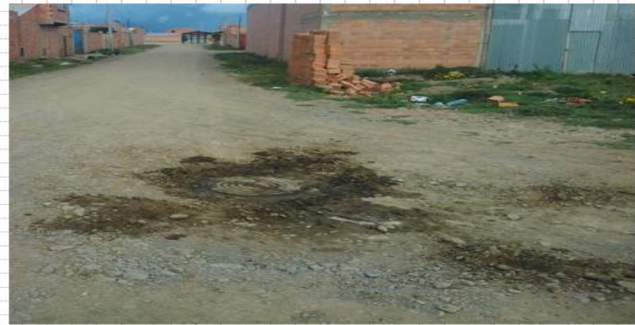
CÁMARA EXTERIOR. MOSTRANDO LAS TAPAS
