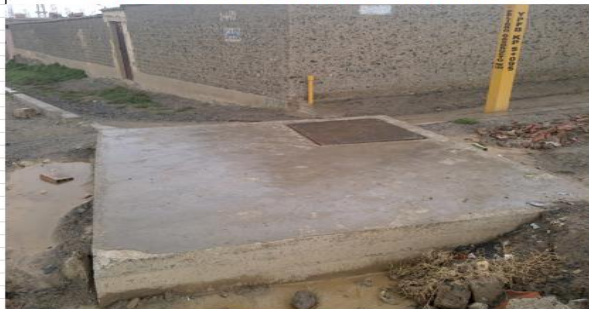
CÁMARA INTERIOR. MOSTRANDO LAS VÁLVULAS
