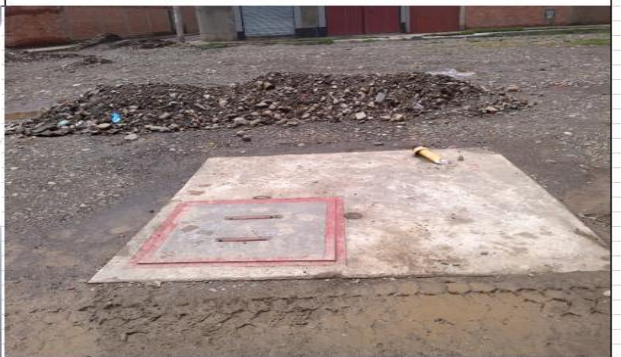
CÁMARA EXTERIOR. MOSTRANDO LAS TAPAS
