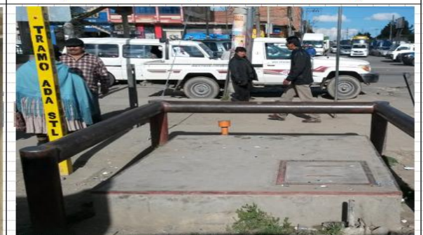
CÁMARA EXTERIOR. MOSTRANDO LAS TAPAS
