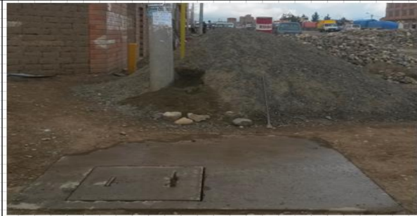
CÁMARA EXTERIOR, MOSTRANDO LAS TAPAS
