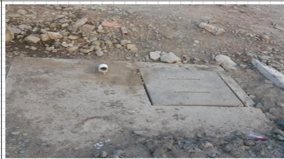
CÁMARA EXTERIOR, MOSTRANDO LAS TAPAS
