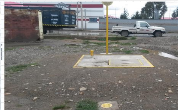
CÁMARA EXTERIOR. MOSTRANDO LAS TAPAS
