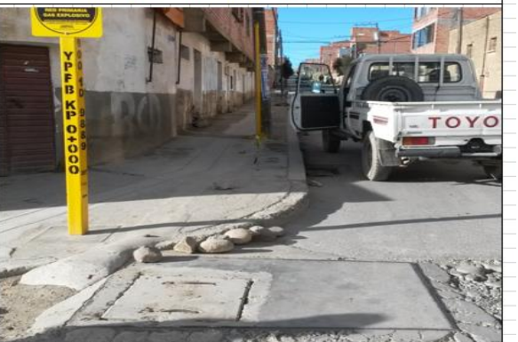
CÁMARA EXTERIOR. MOSTRANDO LAS TAPAS
