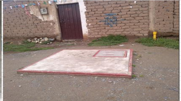
CÁMARA EXTERIOR. MOSTRANDO LAS TAPAS
