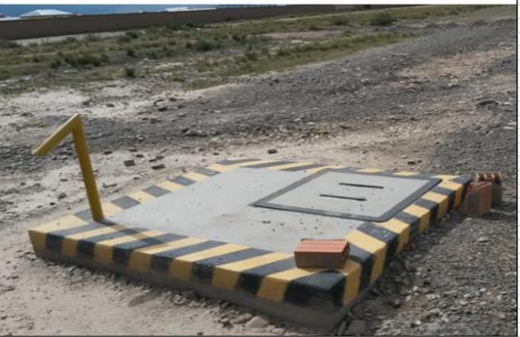
CÁMARA EXTERIOR. MOSTRANDO LAS TAPAS
