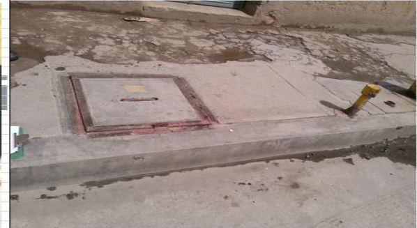
CÁMARA EXTERIOR. MOSTRANDO LAS TAPAS
