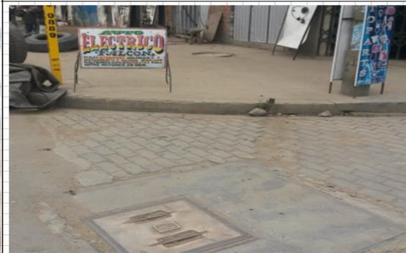
CÁMARA EXTERIOR. MOSTRANDO LAS TAPAS
