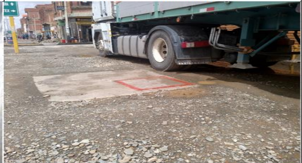
CÁMARA EXTERIOR. MOSTRANDO LAS TAPAS
