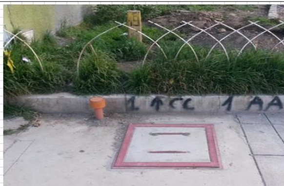
CÁMARA EXTERIOR, MOSTRANDO LAS TAPAS
