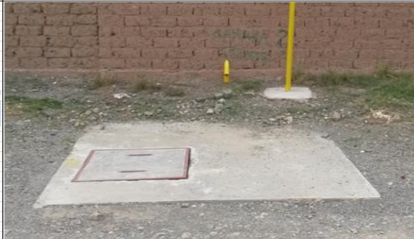
CÁMARA EXTERIOR, MOSTRANDO LAS TAPAS
