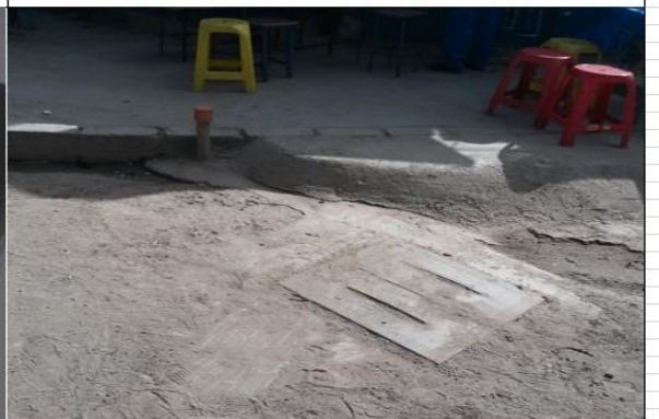
CÁMARA EXTERIOR. MOSTRANDO LAS TAPAS
