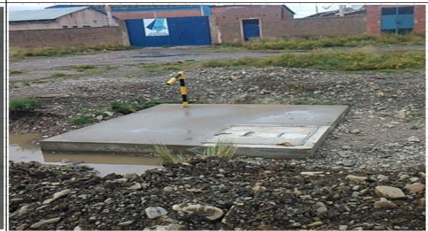
CÁMARA EXTERIOR. MOSTRANDO LAS TAPAS
