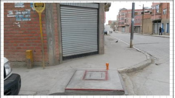
CÁMARA EXTERIOR. MOSTRANDO LAS TAPAS
