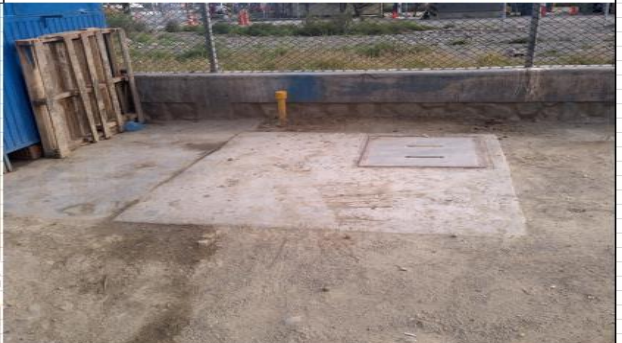
CÁMARA EXTERIOR. MOSTRANDO LAS TAPAS
