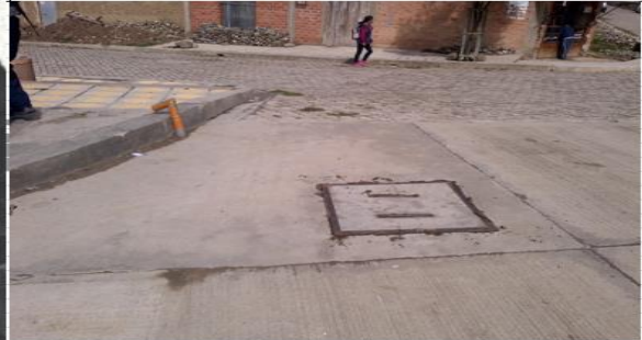
CÁMARA EXTERIOR. MOSTRANDO LAS TAPAS
