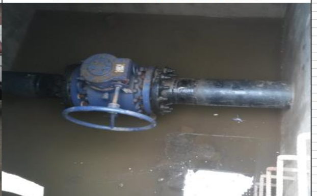
CÁMARA EXTERIOR. MOSTRANDO LAS TAPAS
