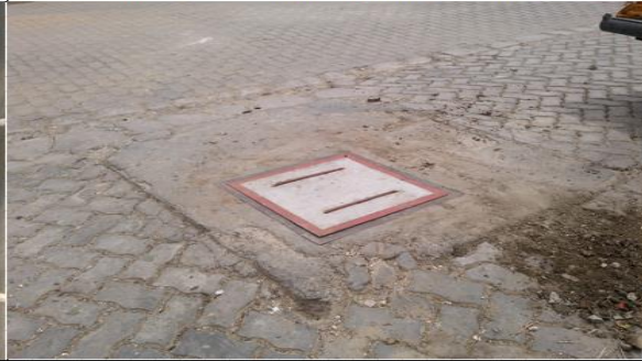
CÁMARA EXTERIOR. MOSTRANDO LAS TAPAS
