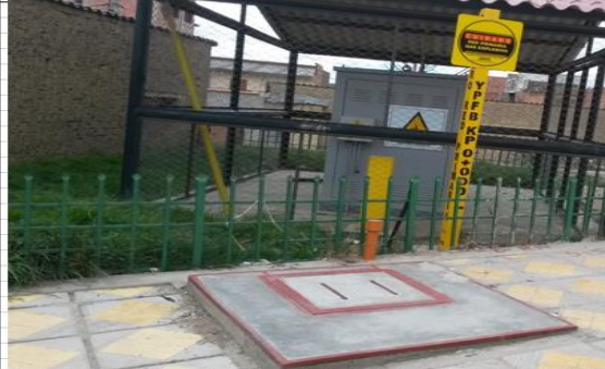
CÁMARA EXTERIOR. MOSTRANDO LAS TAPAS
