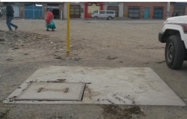
CÁMARA INTERIOR. MOSTRANDO LAS VÁLVULAS
