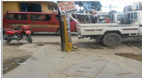
CÁMARA EXTERIOR. MOSTRANDO LAS TAPAS
