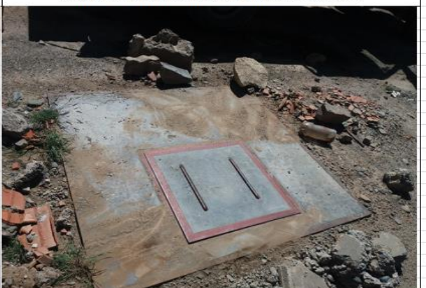
CÁMARA EXTERIOR. MOSTRANDO LAS TAPAS
