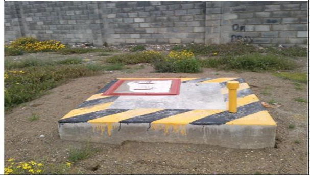
CÁMARA EXTERIOR. MOSTRANDO LAS TAPAS
