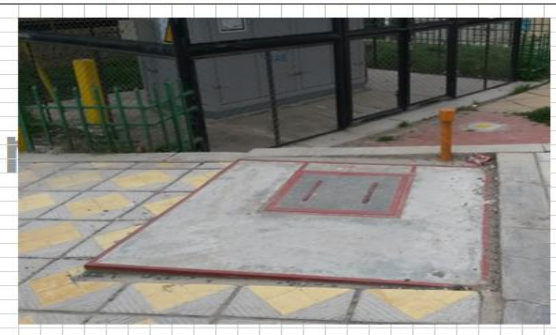
CÁMARA EXTERIOR. MOSTRANDO LAS TAPAS
