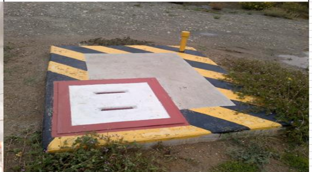
CÁMARA EXTERIOR. MOSTRANDO LAS TAPAS
