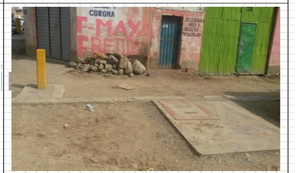
CÁMARA EXTERIOR. MOSTRANDO LAS TAPAS
