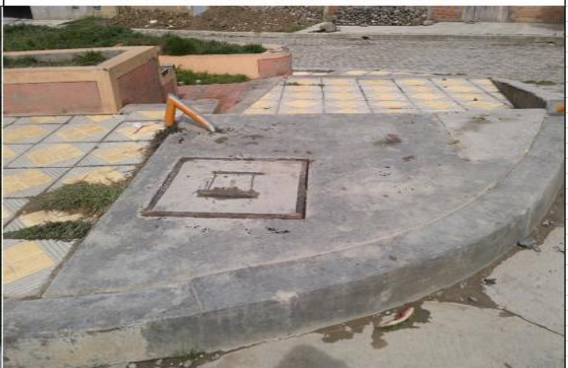
CÁMARA EXTERIOR. MOSTRANDO LAS TAPAS
