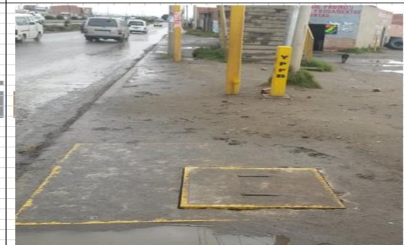
CÁMARA EXTERIOR. MOSTRANDO LAS TAPAS
