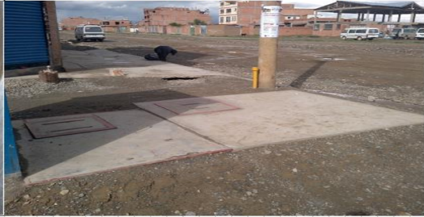
CÁMARA EXTERIOR. MOSTRANDO LAS TAPAS
