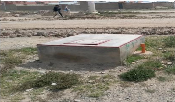
CÁMARA EXTERIOR. MOSTRANDO LAS TAPAS
