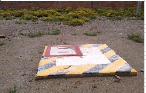
CÁMARA EXTERIOR. MOSTRANDO LAS TAPAS
