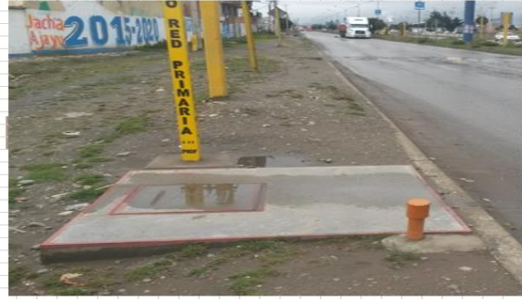
CÁMARA EXTERIOR. MOSTRANDO LAS TAPAS
