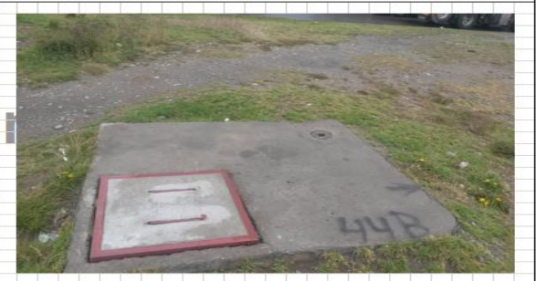
CÁMARA EXTERIOR. MOSTRANDO LAS TAPAS
