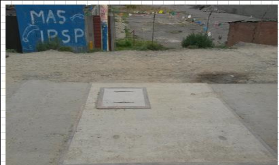
CÁMARA EXTERIOR. MOSTRANDO LAS TAPAS
