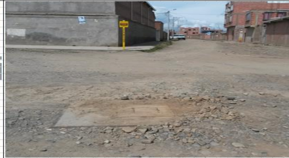
CÁMARA EXTERIOR. MOSTRANDO LAS TAPAS
