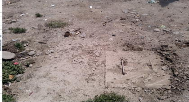
CÁMARA EXTERIOR, MOSTRANDO LAS TAPAS
