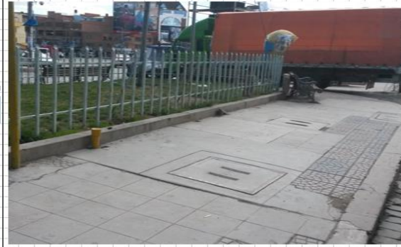
CÁMARA EXTERIOR. MOSTRANDO LAS TAPAS
