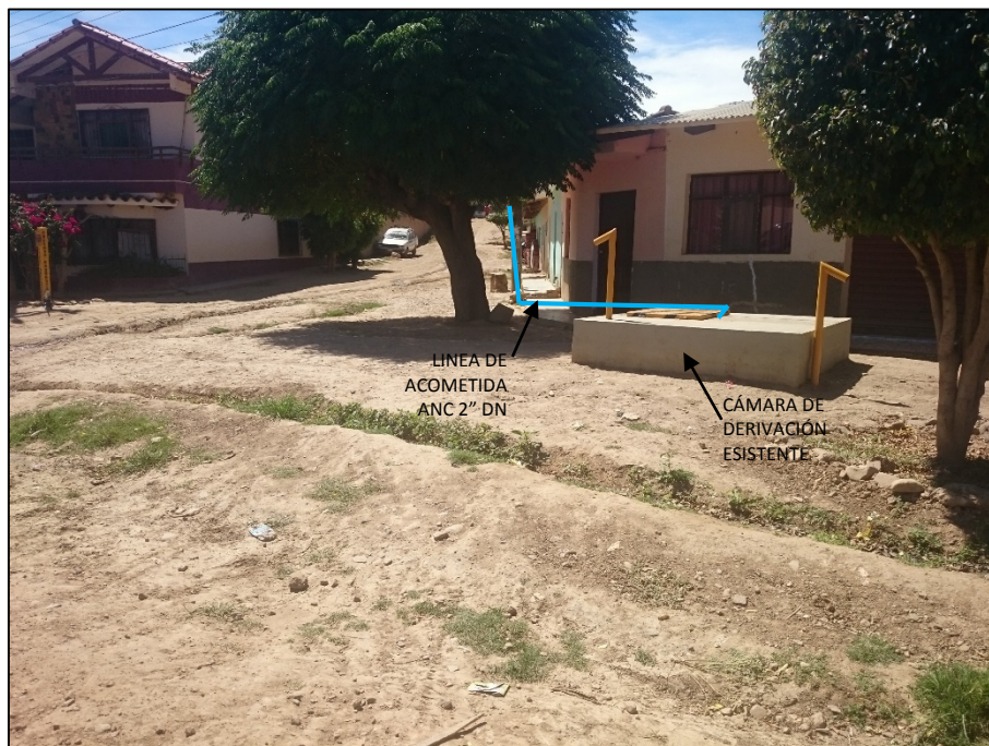
Fig. 4. Línea de acometida EDR San Isidro
