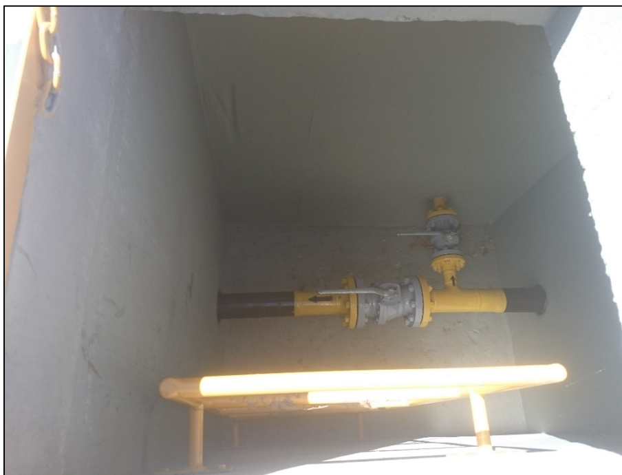
Fig. 8. Cámara de derivación a EDR Tambo
