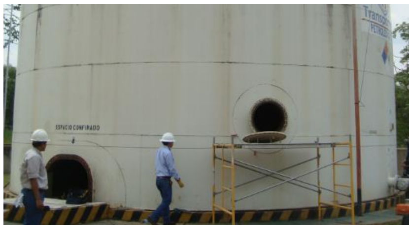
Foto 4. Entrada de hombre y mantenimiento Tanques Humberto Suarez
