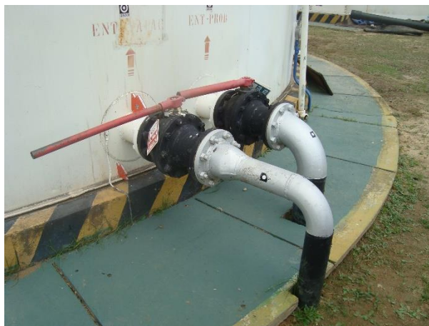
Foto 1. Líneas de entrada y salida de producto Tanques Humberto Suarez
