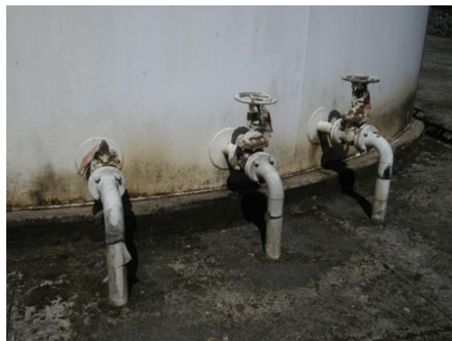
Foto 2. Líneas de entrada y salida de producto Tanque Limatambo
