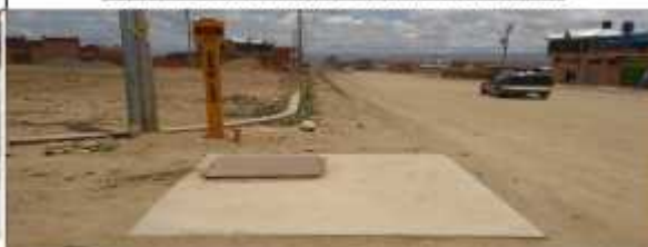
CÁMARA EXTERIOR, MOSTRANDO LAS TAPAS
