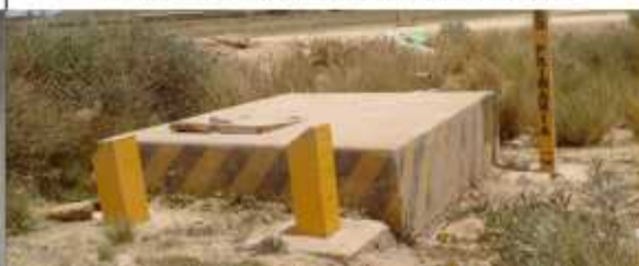
CÁMARA EXTERIOR, MOSTRANDO LAS TAPAS
