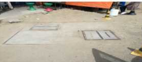
CÁMARA EXTERIOR, MOSTRANDO LAS TAPAS
