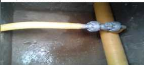
CÁMARA INTERIOR, MOSTRANDO LAS VÁLVULAS
