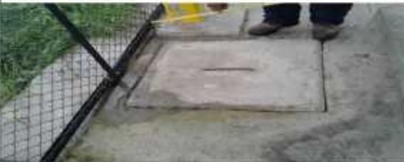
CÁMARA EXTERIOR, MOSTRANDO LAS TAPAS
