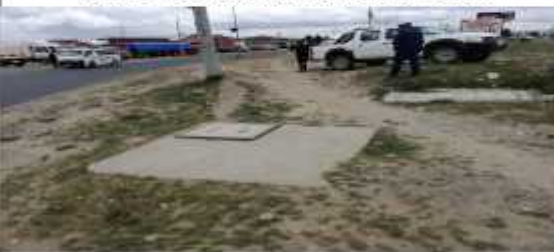
CÁMARA EXTERIOR, MOSTRANDO LAS TAPAS
