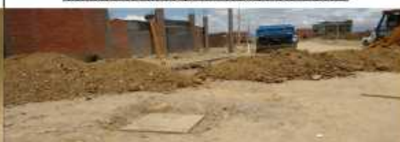
CÁMARA EXTERIOR, MOSTRANDO LAS TAPAS
