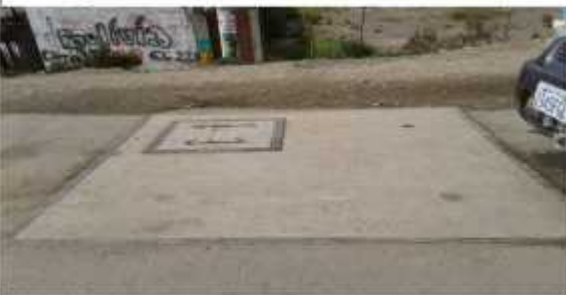
CÁMARA EXTERIOR, MOSTRANDO LAS TAPAS
