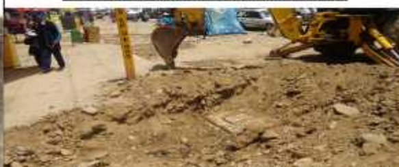
CÁMARA EXTERIOR, MOSTRANDO LAS TAPAS
