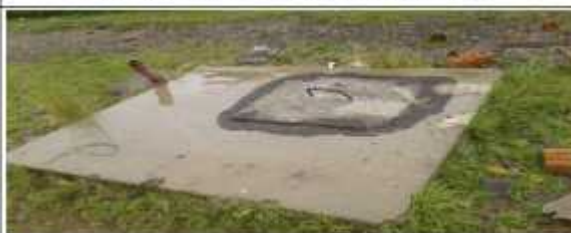
CÁMARA EXTERIOR, MOSTRANDO LAS TAPAS
