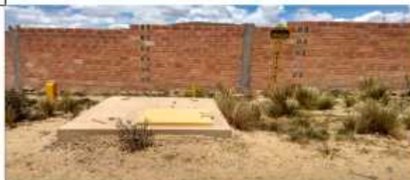
CÁMARA EXTERIOR, MOSTRANDO LAS TAPAS
