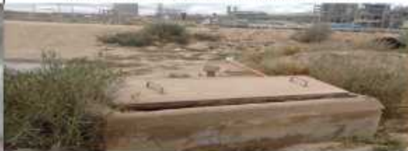
CÁMARA EXTERIOR, MOSTRANDO LAS TAPAS
