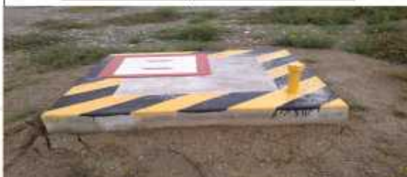
CÁMARA EXTERIOR, MOSTRANDO LAS TAPAS
