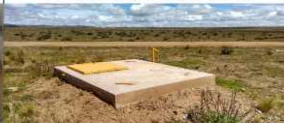
CÁMARA EXTERIOR, MOSTRANDO LAS TAPAS
