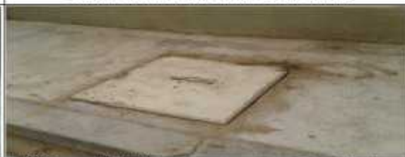
CÁMARA EXTERIOR, MOSTRANDO LAS TAPAS
