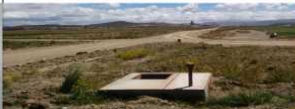
CÁMARA EXTERIOR, MOSTRANDO LAS TAPAS
