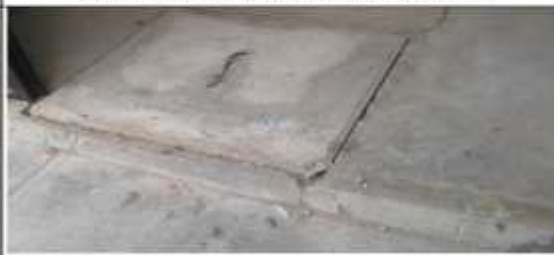
CÁMARA EXTERIOR, MOSTRANDO LAS TAPAS
