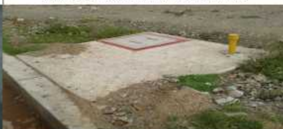
CÁMARA EXTERIOR, MOSTRANDO LAS TAPAS
