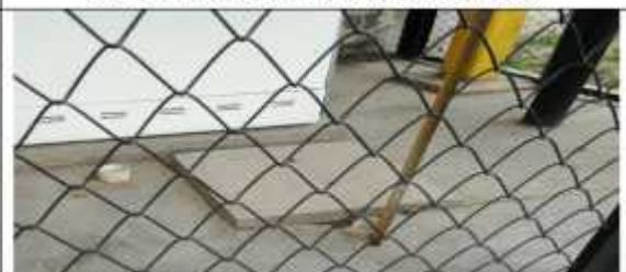
CÁMARA EXTERIOR, MOSTRANDO LAS TAPAS
