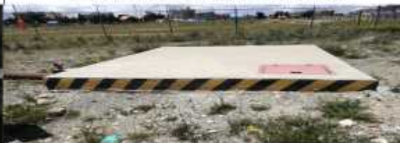
CÁMARA EXTERIOR, MOSTRANDO LAS TAPAS
