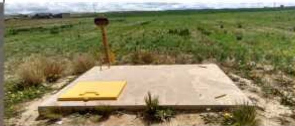
CÁMARA EXTERIOR, MOSTRANDO LAS TAPAS
