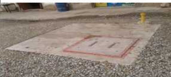
CÁMARA EXTERIOR, MOSTRANDO LAS TAPAS
