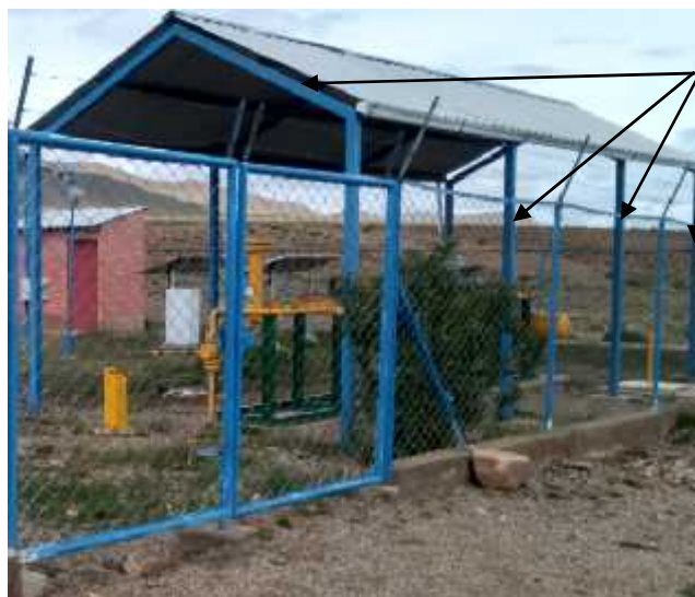
Vigas tipo "C" del techo - City Gate
