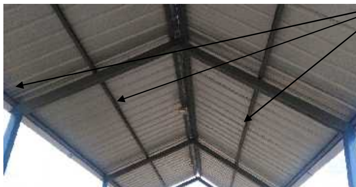
Vigas tipo "C" del techo - City Gate
