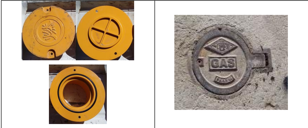
GRÁFICO 5. TIPOS DE TAPA PARA CÁMARAS EN RED SECUNDARIA INSTALADOS
