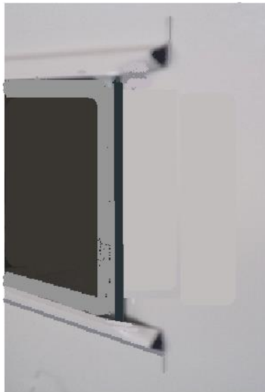
Fig. VISOR DE VIDRIO ADHERIDO CON SILICONA EN PUERTAS PINTADAS
