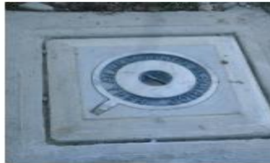
CAJA DE INSPECCIÓN
