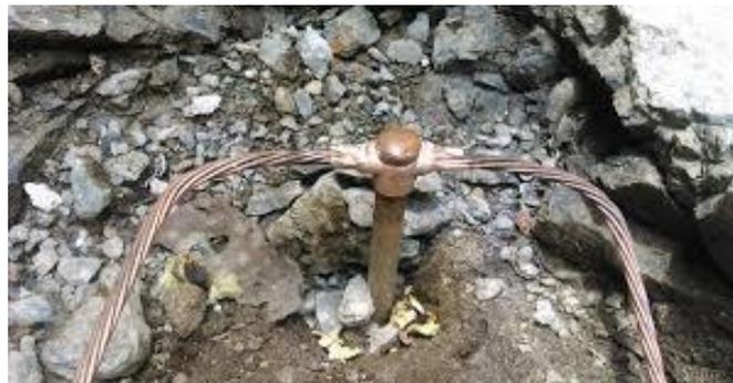
La instalación de la primera jabalina y la cámara de inspección del Sistema de Puesta a Tierra al EDR deberán estar a una distancia mínima de 2m.
