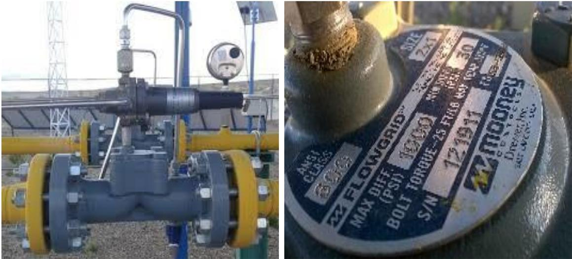
Regulador: primera y segunda etapa: FLOWGRID Dresser Mooney, fabricación americana Tipo diafragma Modelo: FG 53-35/FG 53-50 DH, Conexión: brida 2 ANSI 600RF; Presión máxima de servicio: 1440 psi. Sistema de regulación: WORKING MONITOR SYSTEM.
