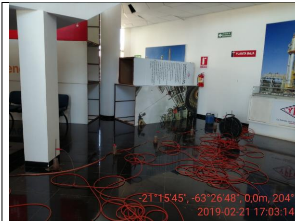
Foto 14 y 15: se observa el tendido de la L4 dentro del hall del edificio y pasa por debajo de la escalera.
