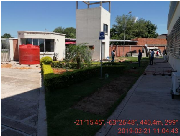
Foto 7: se observa el tendido de la L3 hacia el lado Oeste o exterior del edificio.
