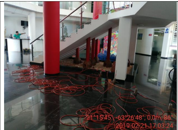
Foto 14 y 15: se observa el tendido de la L4 dentro del hall del edificio y pasa por debajo de la escalera.
