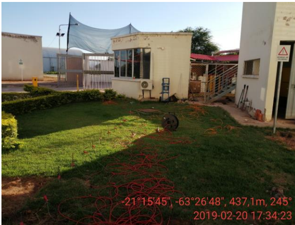
Foto 5: se observa el tendido de la L2 hacia el lado Oeste o exterior del edificio.
