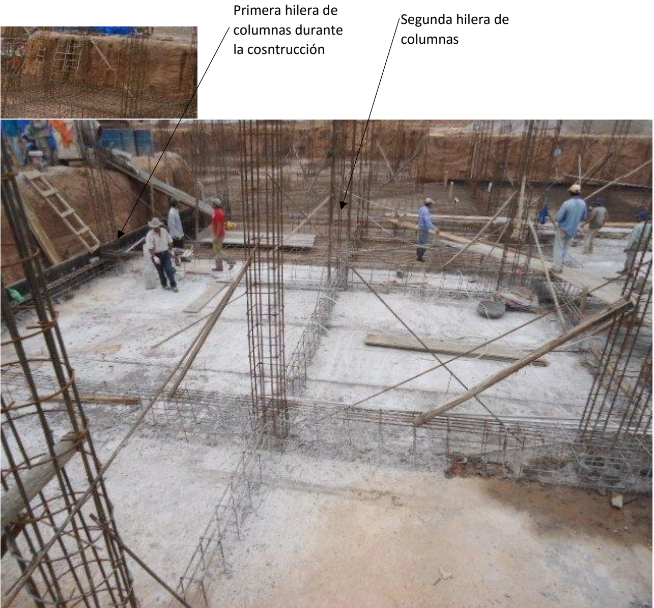
Foto 9: se observan las estructuras de hierro de las hileras de columnas durante la construcción.
