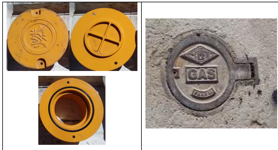
GRÁFICO 4. TIPOS DE TAPA PARA CÁMARAS EN RED SECUNDARIA INSTALADOS
