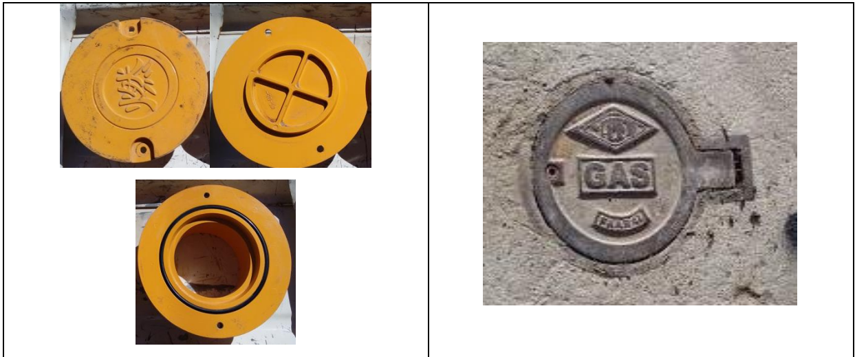
GRÁFICO 4. TIPOS DE TAPA PARA CÁMARAS EN RED SECUNDARIA INSTALADOS
