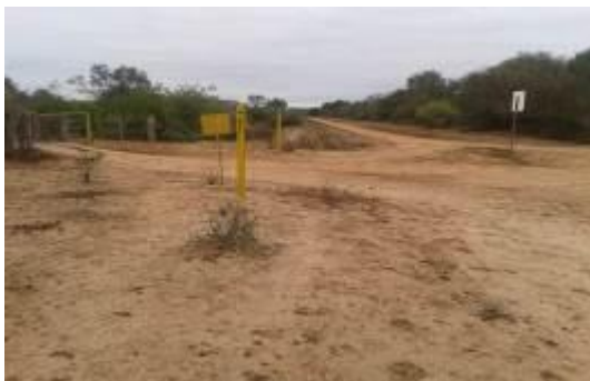
Foto-01 Camino de Acceso y DDV Gasoducto
