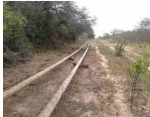
Foto-04 DDV Gasoducto lado oeste del Complejo
