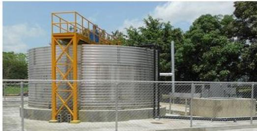
Planta de Tratamiento Compacta tipo Monotanque
