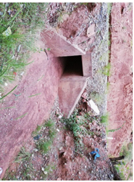
LASTRADO A 5.5 m EN LONGITUD DE 3.5m
